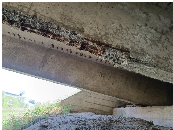
7 pav. Ištrupėjusęs apsauginis sijų betono sluoksnis, atsivėrusi armatūra
