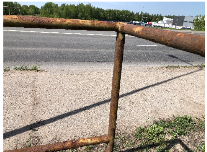
4 pav. Korozijos pažeisti viaduko turėklai
