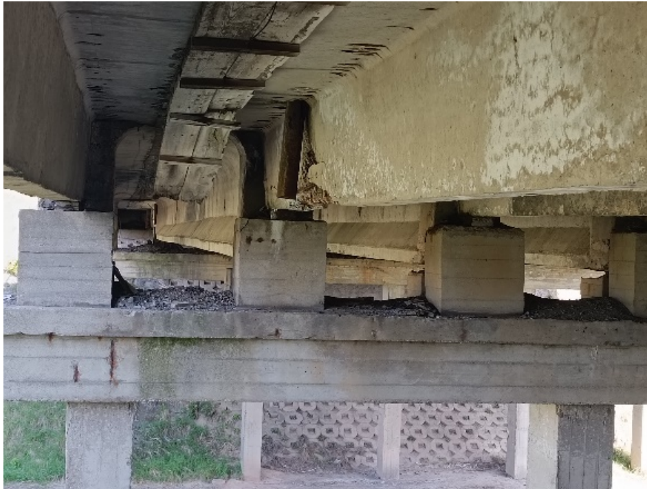
8 pav. Perdangos pažeidimai atsiradę nuo netinkamai įrengtos lietaus nubėgimo sistemos
