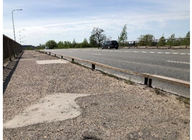
3 pav. Korozijos pažeisti viaduko atitvarai
