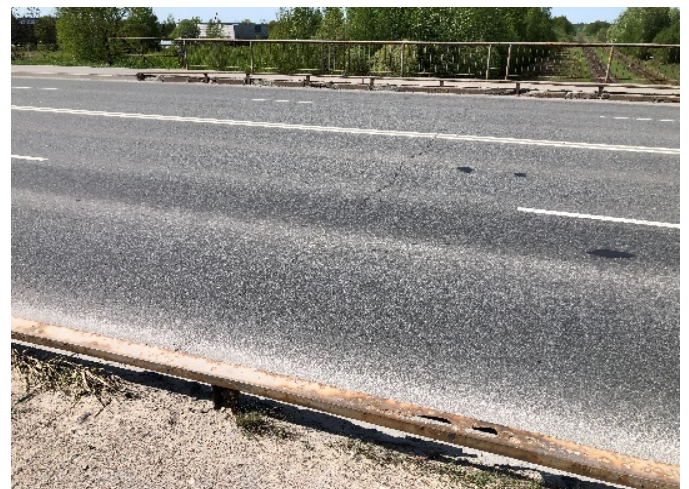
5 pav. Neįrengti deformaciniai pjūviai
