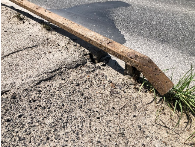
3 pav. Korozijos pažeisti viaduko atitvarai
