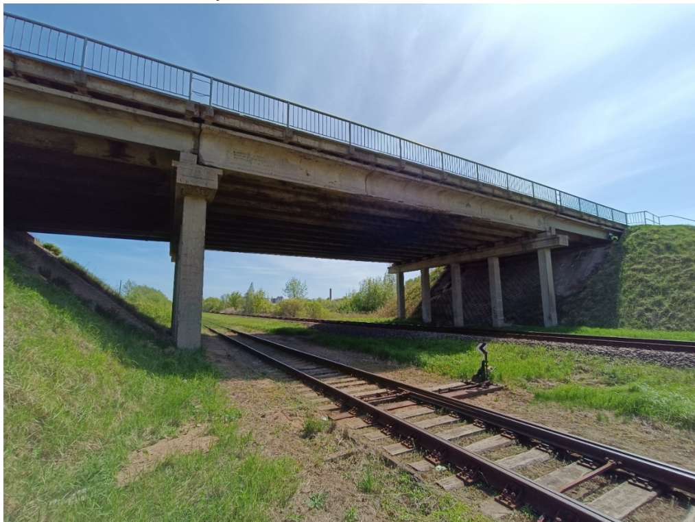
2 pav. Viaduko Pramonės g. fasadas
