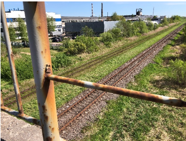
4 pav. Korozijos pažeisti viaduko turėklai
