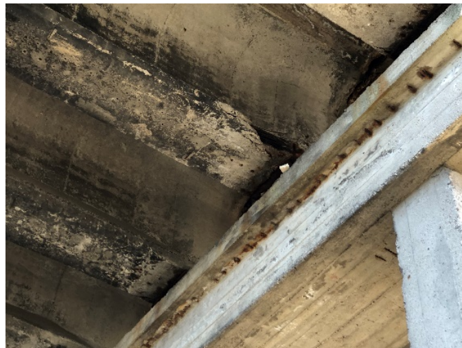
7 pav. Ištrupėjusęs apsauginis sijų betono sluoksnis, atsivėrusi armatūra
