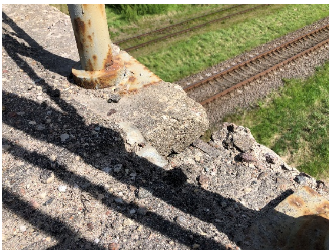
5 pav. Neįrengti deformaciniai pjūviai
