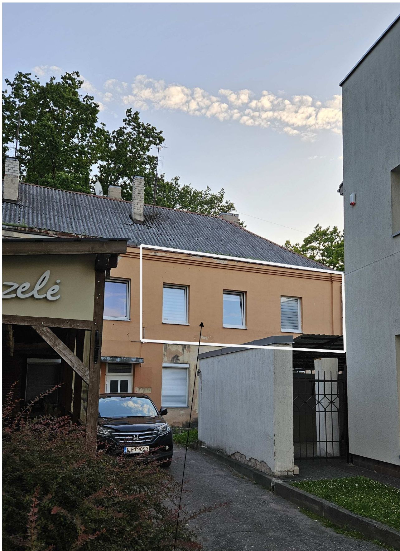
Patalpa Kranto 7A-8, kurios paskirtis keičiama į gyvenamąją
