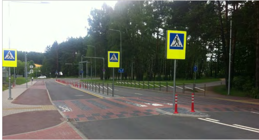
4.2 pav. Geroji praktika: Pėsčiųjų perėja su inžineriniais saugos elementais Šaltinis: konsultanto fotofiksacija
