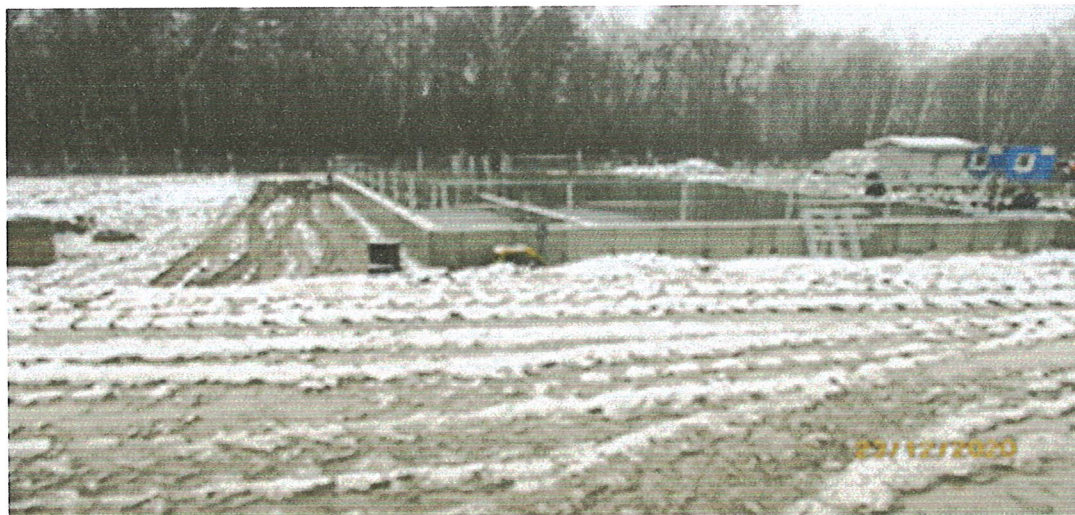
26 pav. Naujai statomas sąvartyno nuotekų surinkimo rezervuaras
