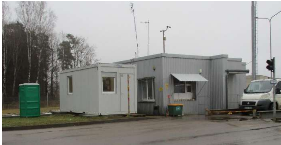
32 pav. Konteinerinės patalpos
